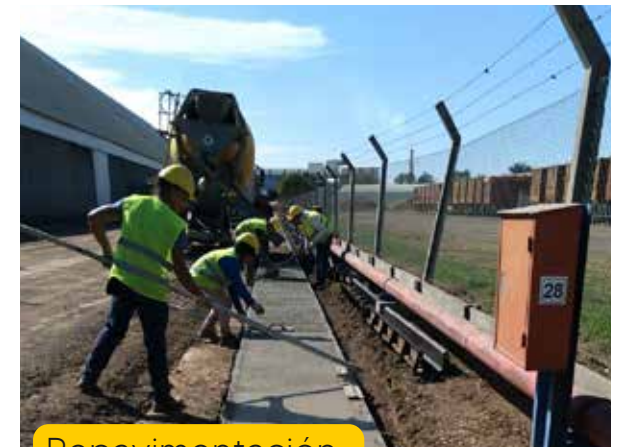
Repavimentación en Prodeman.
