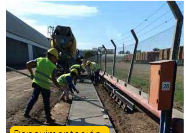
Repavimentación en Prodeman.
